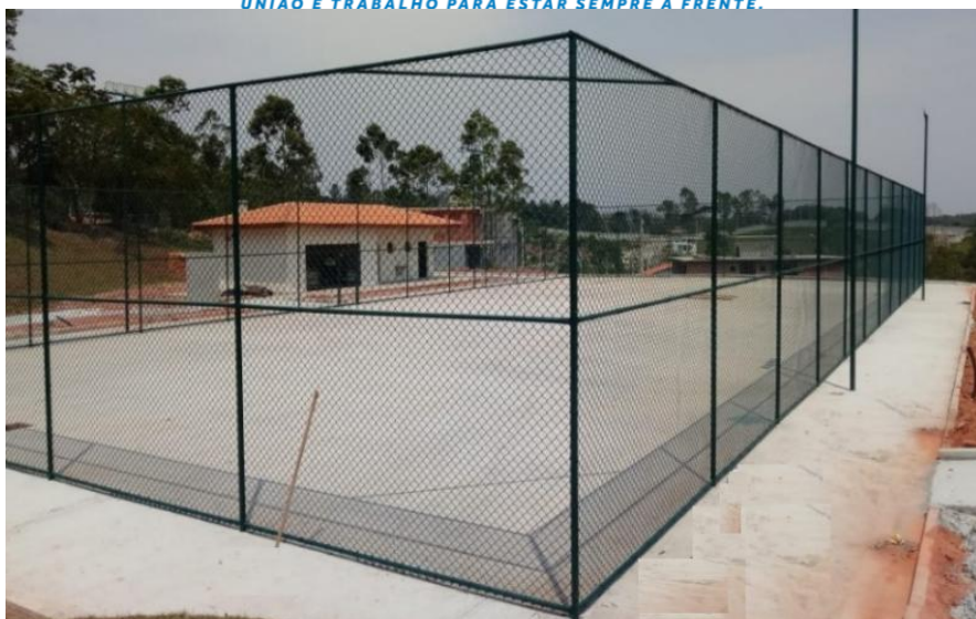
Imagem 4: Exemplo de travamento da parte inferior do alambrado. Fonte: Internet.
