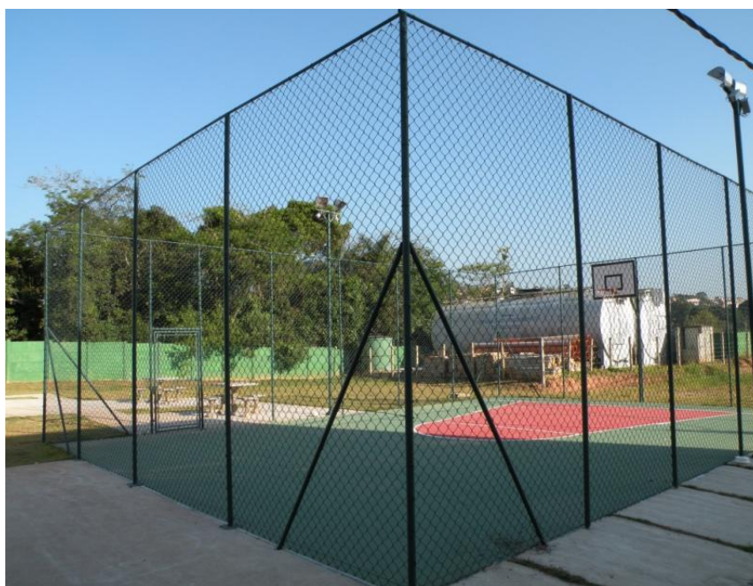
Imagem 5: Exemplo de travamento da parte superior do alambrado. Fonte: Internet.
